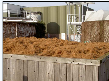
Lieferung von Filterkörnern für den HKP Geruchsfilter
