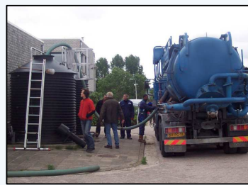
Aussaugen der veralteten Ergussgesteine aus dem Lavafilter
