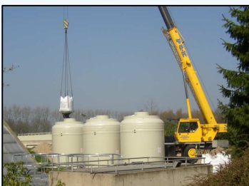
Ausfüllen der Lavafilter
