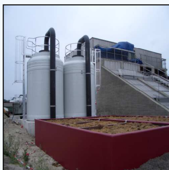
"Staffelstein" lavafilters en compostbakken in GVK en PE
