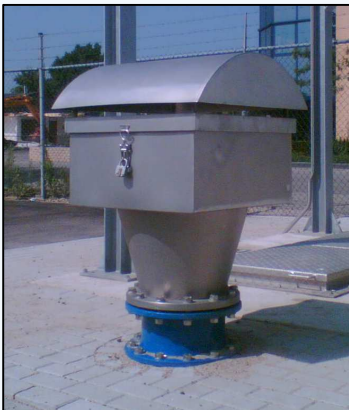
HKP Geruchsfilter für Pumpwerke
