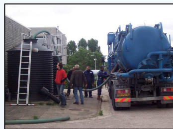
Aussaugen der veralteten Ergussgesteine aus dem Lavafilter
