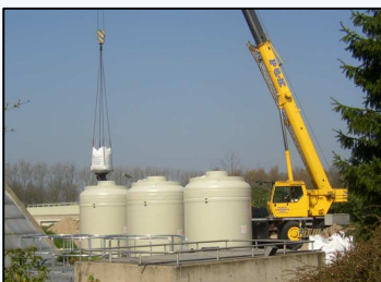
Ausfüllen der Lavafilter
