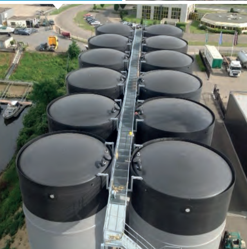
GVK opslagtanks voor biergist, olien en vetten Ø 8.000 mm x H 18.000 mm
