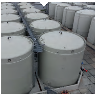
GVK opslagtanks voor biergist, olien en vetten Ø 8.000 mm x H 18.000 mm
