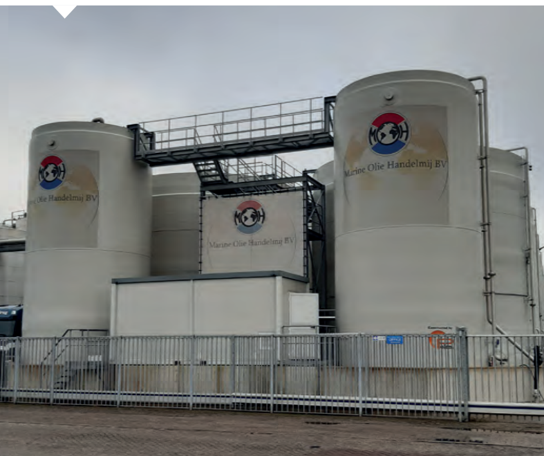
GVK opslagtanks voor oliën en vetten Ø 9.100 mm x H 10.000 mm
