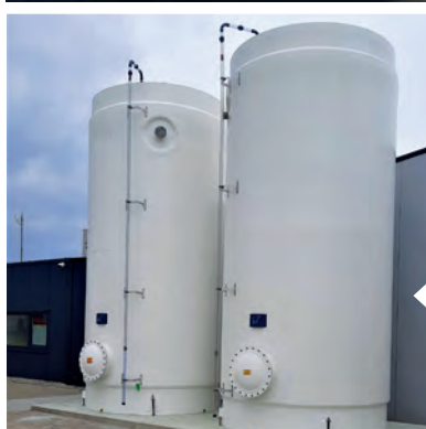
GVK opslagtanks voor vloeibare kunstmest Ø 5.000 mm x H 14.500 mm
