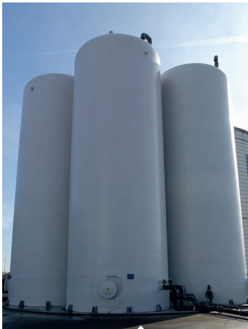
GVK opslagtanks voor vloeibare kunstmest Ø 5.000 mm x H 14.500 mm
